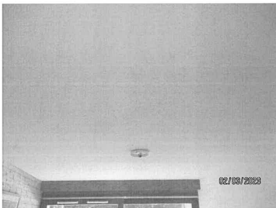
Plafond pièce principale
