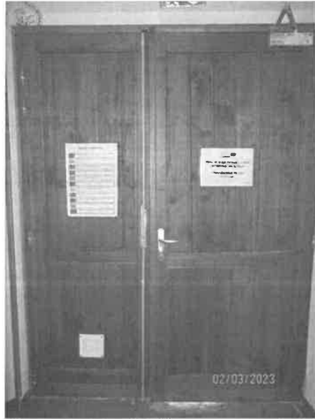
Photographie n°13 (Porte accès principale).
