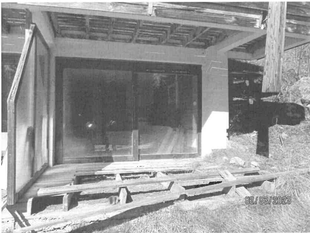
Vue sur terrasse
