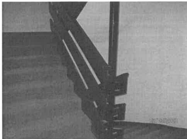
Photographie n°12 (cage d'escalier).
