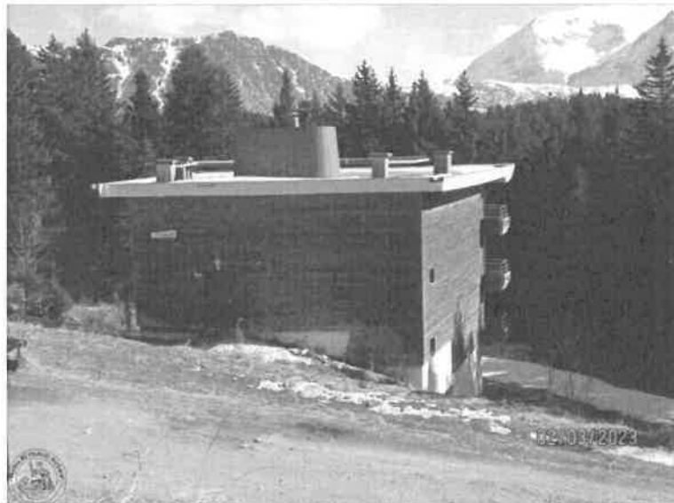
Photographie n°4. Façade Nord-Ouest, accès principal immeuble.
