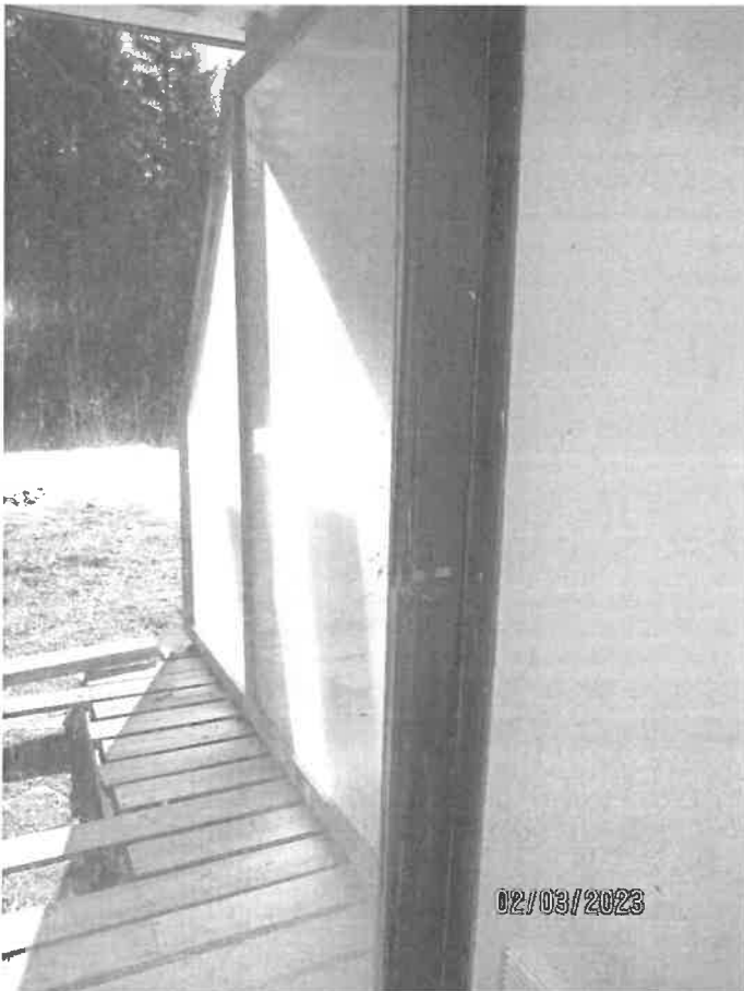
Baie vitrée accès terrasse
