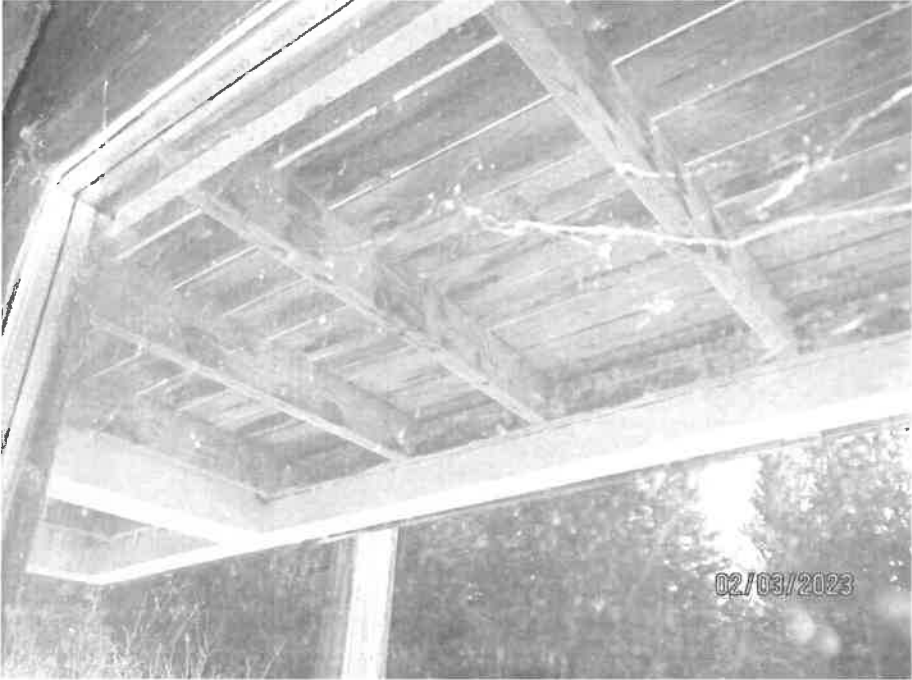
Plafond terrasse (sous face balcon supérieur)
