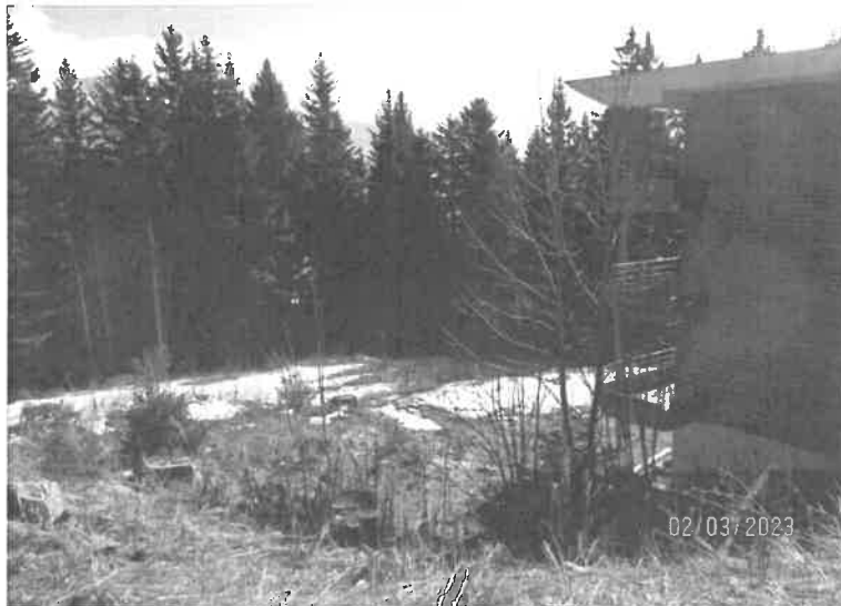
Photographie n°7. Abords Façade Nord-Ouest.
