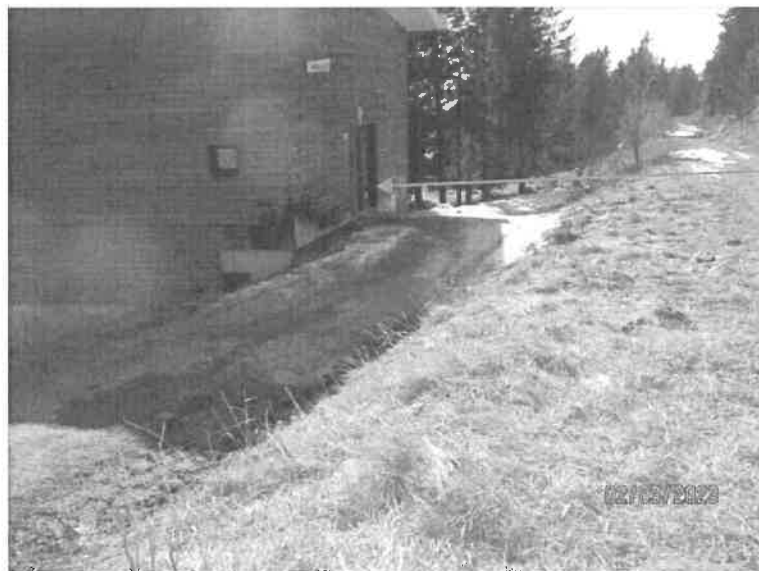
Photographie n°5. Façade Nord-Ouest, accès principal immeuble.
