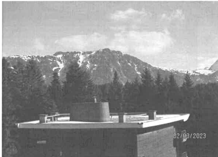
Photographie n°6. Toit Terrasse.
