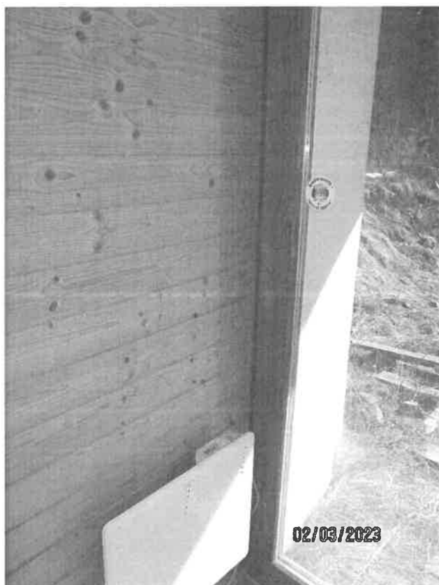
Baie vitrée accès terrasse
