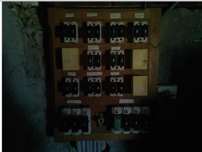
Description : Le type d'au moins un FUSIBLE ou un DISJONCTEUR n'est plus autorisé (fusible à tabatière, à broches rechargeables, COUPE-CIRCUIT A FUSIBLE de type industriel, DISJONCTEUR réglable en courant protégeant des CIRCUITS terminaux).
