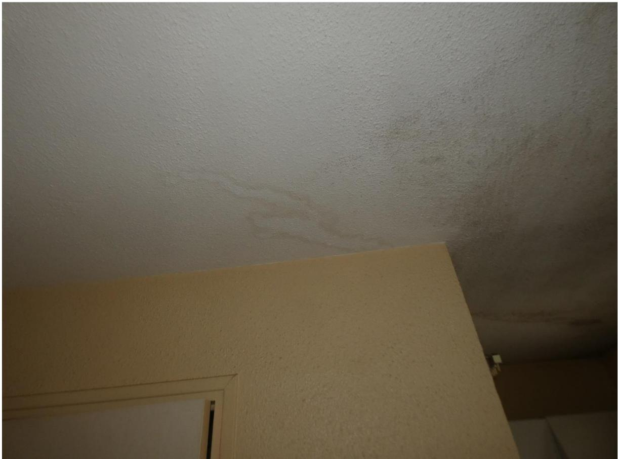
Une fissure est visible à la gauche de la porte d'accès à la salle de bains.
