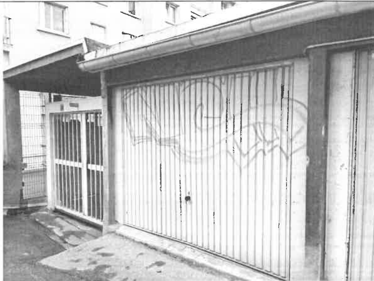
Photographie n°3 : A gauche accès sous-sol et droite garage n°35.
